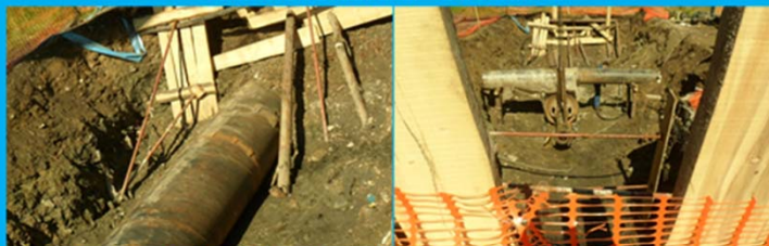
Conducta refulare SP2 – Strada Digului – Supratraversare pod
