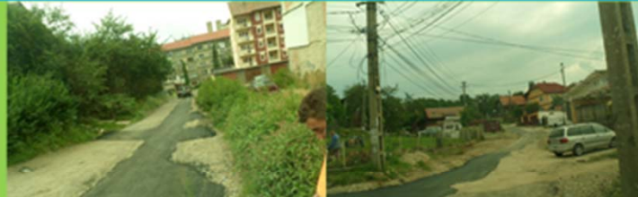
Canalizare Petrosani – Str. Uzinei
