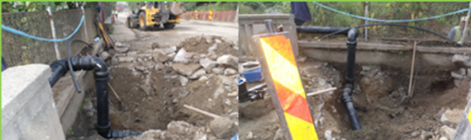
Canalizare Petrosani – Str. Uzinei – Teste
