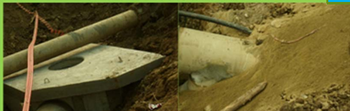
Canalizare Petrosani – Str. Uzinei
